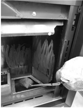
Rys. 26 - Czyszczenie za pomocą środka do czyszczenia rur
