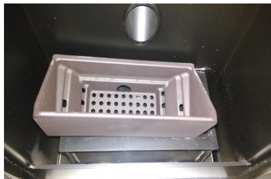
PRZYKŁAD NIEPOPRAWNEGO MONTAŻU
