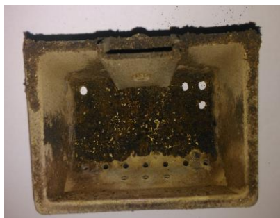
RUSZT KTÓRY WYMAGA CZYSZCZENIA
